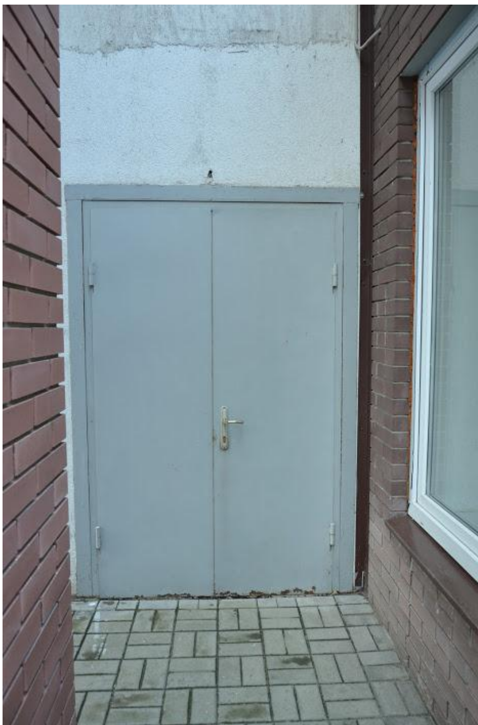
Рис. 10 Вхід до лекційного корпусу
